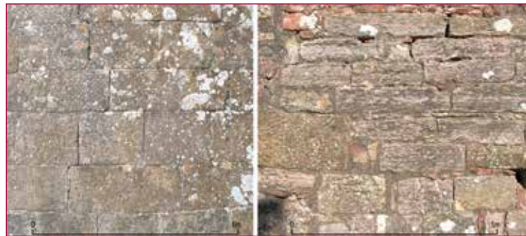
Fig. 4 - Campioni di tecnica muraria, a sinistra fase 1 (abside) e a destra fase 2 (paramento esterno sud).
